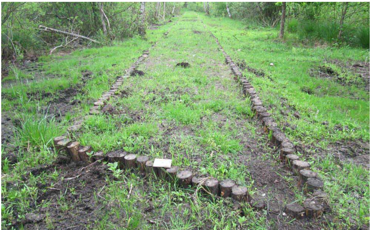
Торф'яна дамба, посилена дерев'яними елементами.
