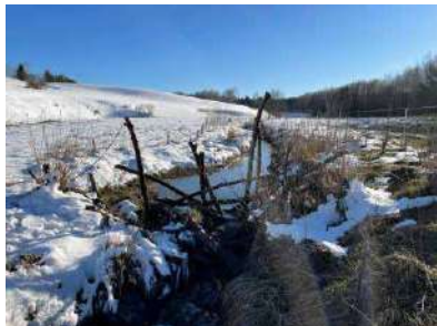
Імітація бобрової загати, яка блокує дренажний канал в Бещадах з використанням вербових гілок – від побудови восени до наступного літа. Фото: Andrzej Czech.
