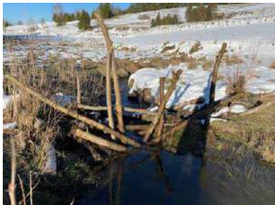
Імітація бобрової загати, яка блокує дренажний канал в Бещадах з використанням вербових гілок – від побудови восени до наступного літа. Фото: Andrzej Czech.
