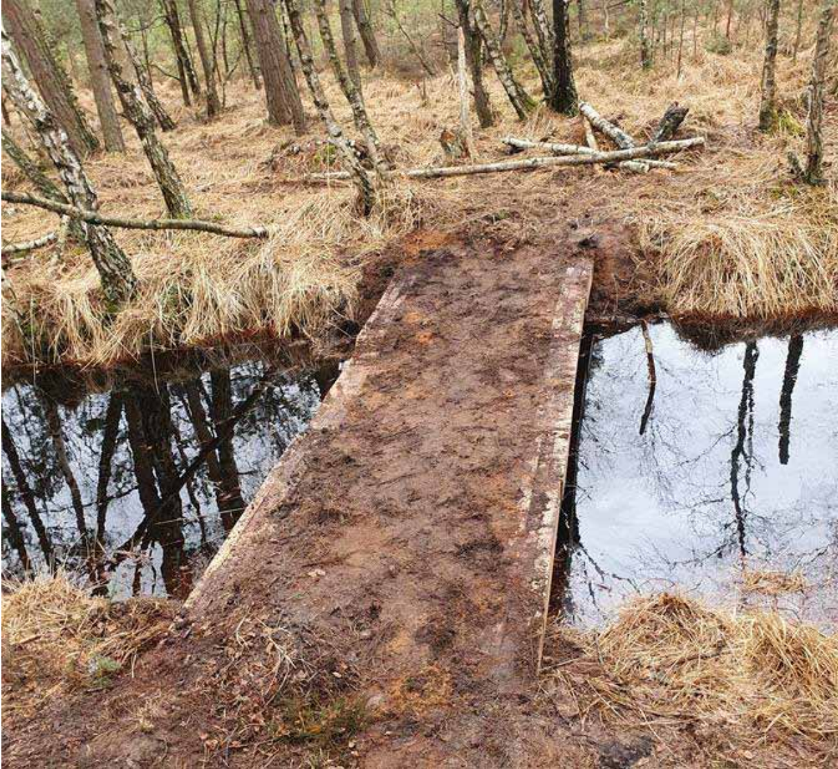
Блокування каналів в проєкті PeatRestore в Польщі.
