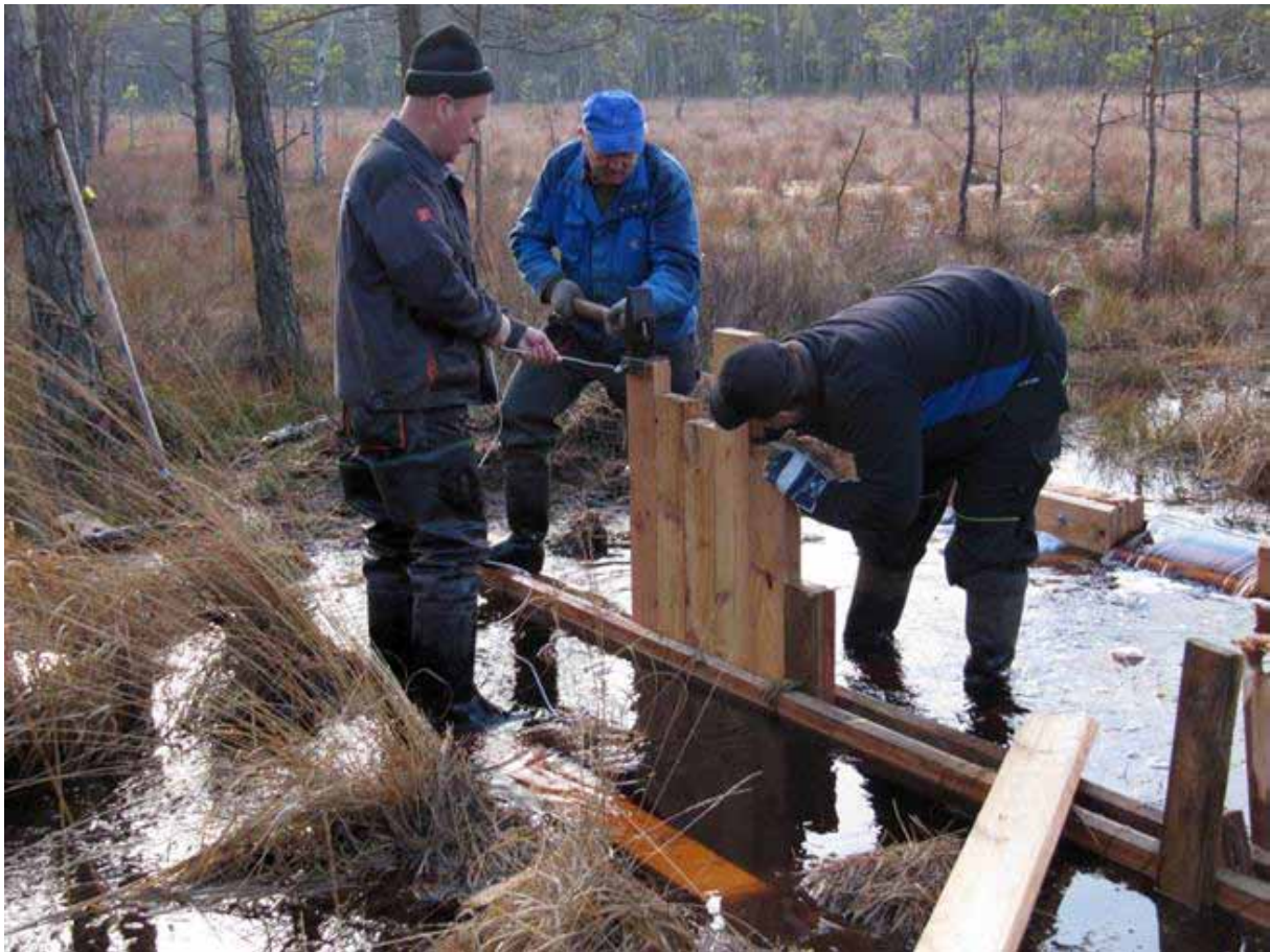
Блокування каналів у балтійському проєкті збереження боліт.
