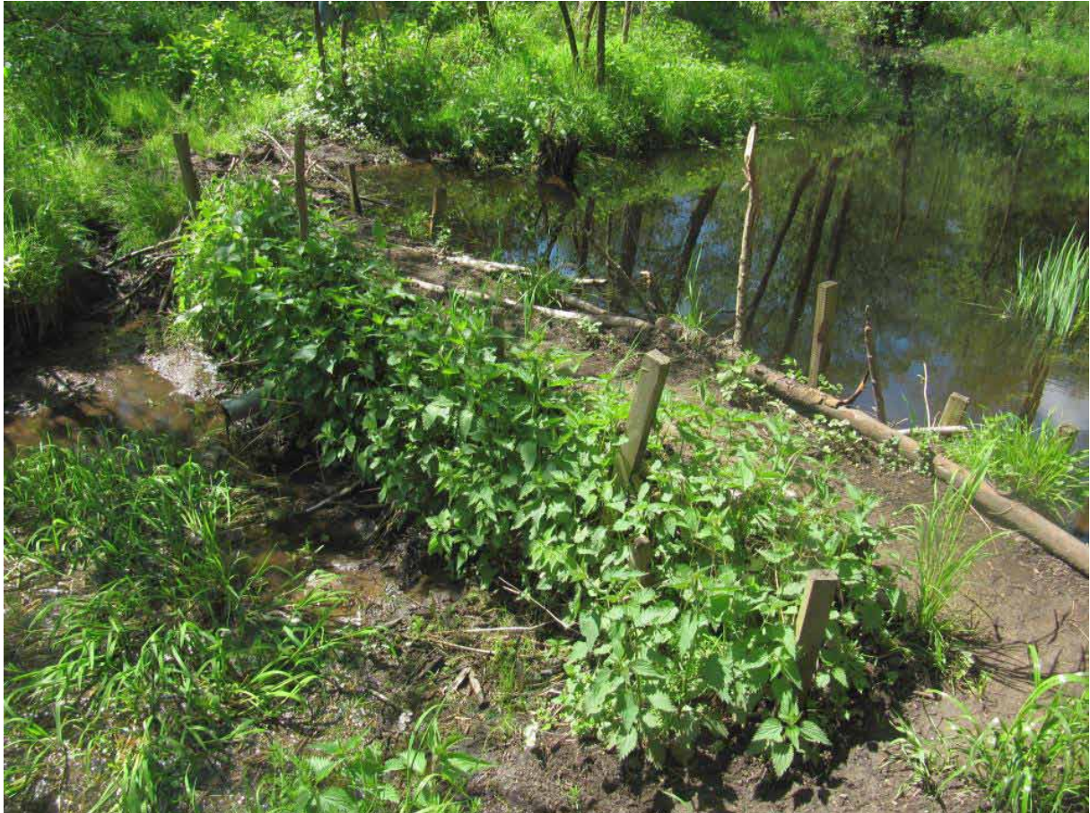
Імітація бобрової загати, зроблена місцевим фермером у Велькопольському воєводстві для утримання води на території ферми.
