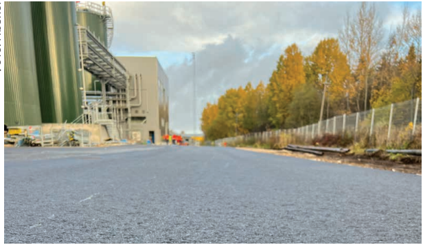
Лигнин может заменить битум в асфальтобетонных смесях. „Деревянный“ участок дороги на фото расположен на пилотном заводе Fibernol в Имавере, построенном в сотрудничестве с TalTech и установленном Tariston.
